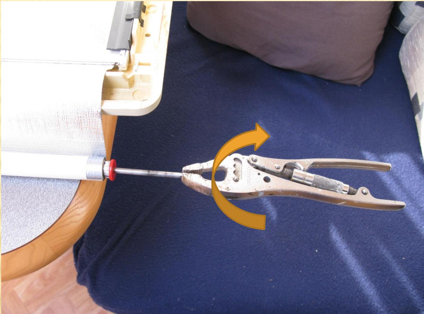
Le ressort dans le tube est complètement détendu. Tenir le tube. Avec la pince tourner l'axe de l'enrouleur pour tendre le ressort. ( le plus délicat trouver la bonne tension du ressort )
